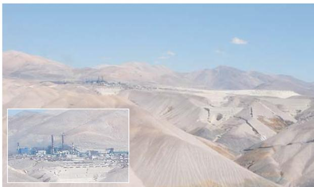
El Salvador ubicado en la comuna de Diego de Almagro, a los 2.600 msnm, explota minerales oxidados y sulfurados a partir de los cuales produce 77.520 toneladas métricas finas de cátodos de cobre al año. Además, produce 1.248 toneladas métricas de molibdeno y se obtienen barros anódicos y ácido sulfúrico.
